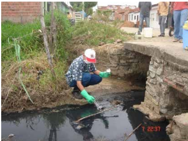
Figura 5 – Rua Maria de F. Barreto Cavalcante. Fonte: Laudo Técnico Pericial (2010).
